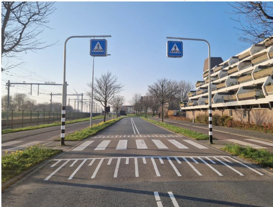
Figuur 2 Voorbeeld lichtbakken met bord voetgangersoversteekplaats
