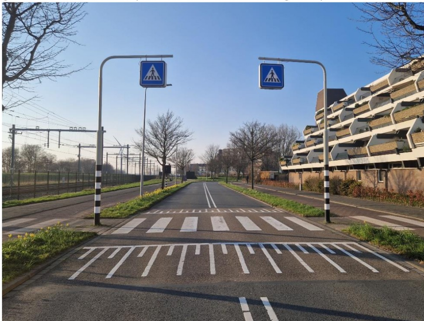
Figuur 2 Voorbeeld lichtbakken met bord voetgangersoversteekplaats
