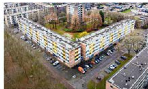
De 'Langenhof' in Amsterdam. Dit gebouw wordt in twee delen in twee delen gesloopt en opnieuw gebouwd.
