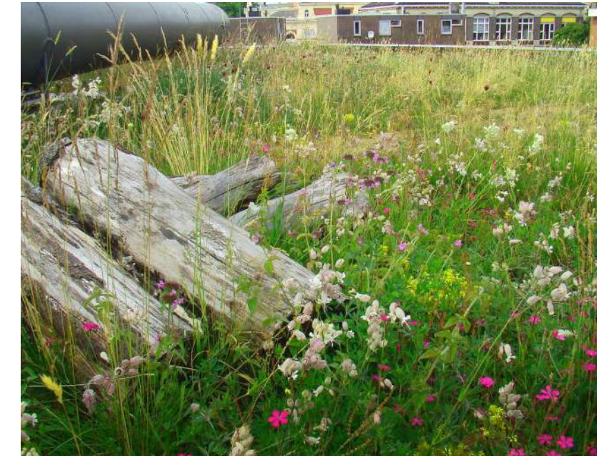
De basis van het sportdak is extensieve bloem- en kruidenrijke vegetatie aangevuld met bollen voor de voorjaarsbeleving.
