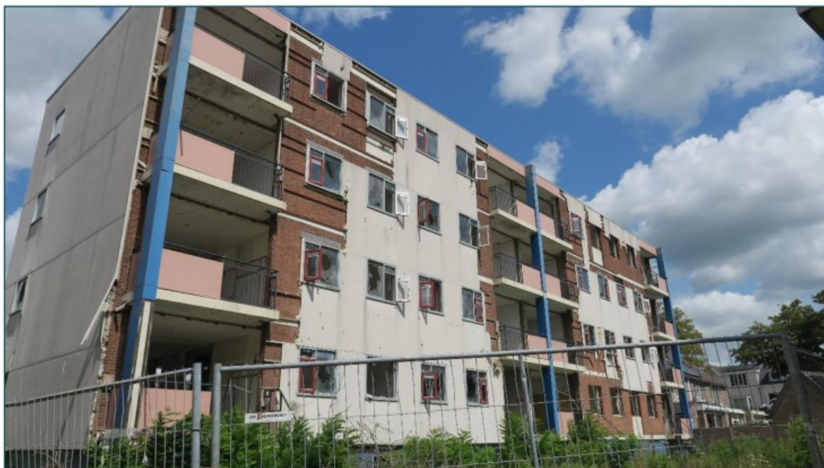
Figuur 1 De planlocatie is gelegen aan de Blaak 1 t/m 95 en bestaat uit portiekwoningen met rondom een verwilderde groenstrook. De beoogde ruimtelijke ingreep betreft de sloop van de woningen en de realisatie van nieuwe woningen.
