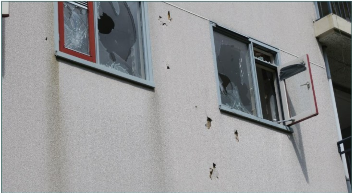
Figuur 3.2 De gevels van het westelijk gelegen woonblok zijn intacter dan het oostelijk gelegen woonblok. Er zijn openingen aanwezig in de gevelbeplating die kunnen leiden naar mogelijk geschikte plekken voor vleermuizen.
