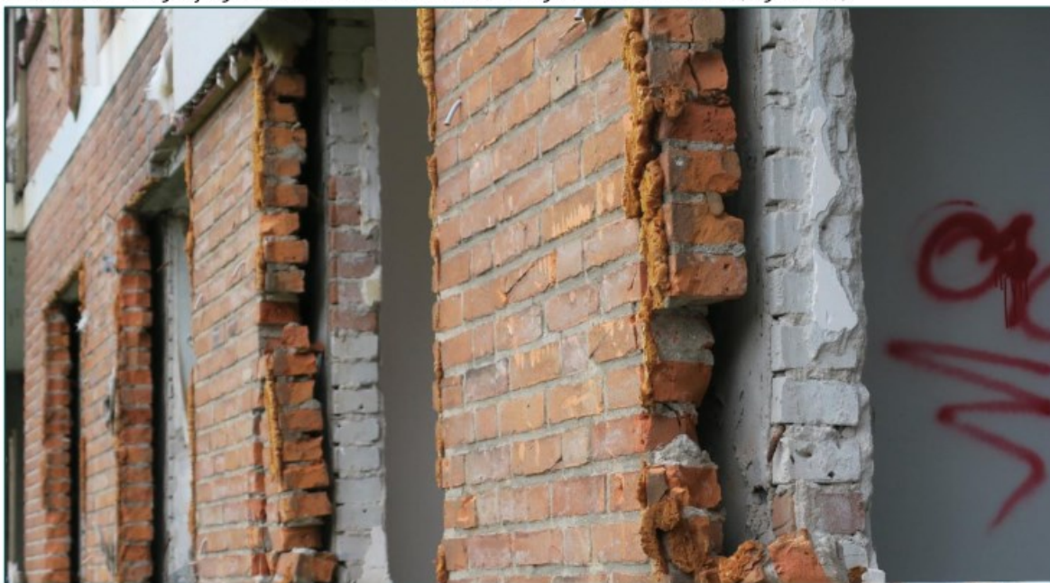
Figuur 3.1 De ruimte tussen de bakstenen muren ligt open in het oostelijk gelegen woonblok. Omdat de spouwruimte mogelijk naar boven doorloopt, kan er een geschikt microklimaat aanwezig zijn voor vleermuizen.
