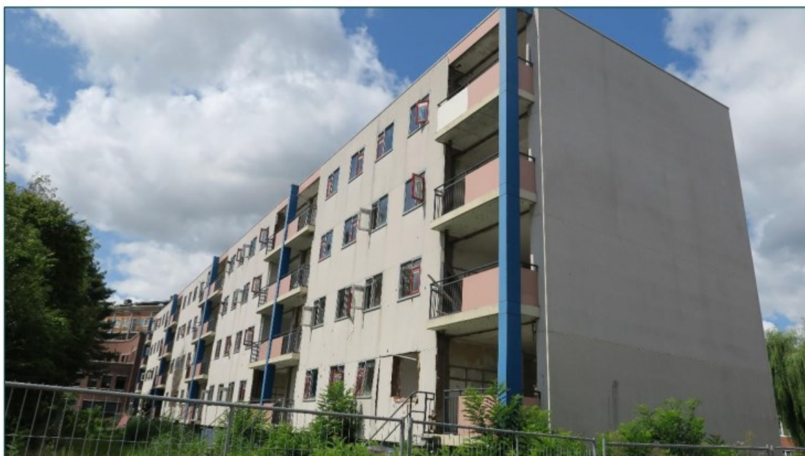
Figuur 2 De bebouwing bestaat uit portiekwoningen met kunststof gevelbeplating.
