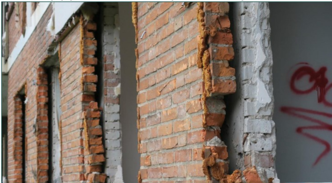
Figuur 3.1 De ruimte tussen de bakstenen muren ligt open in het oostelijk gelegen woonblok. Omdat de spouwruimte mogelijk naar boven doorloopt, kan er een geschikt microklimaat aanwezig zijn voor vleermuizen.
