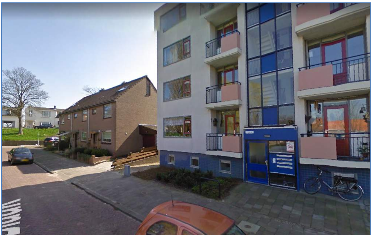
Figuur: Naastgelegen rijwoningen en te slopen appartementencomplex.
