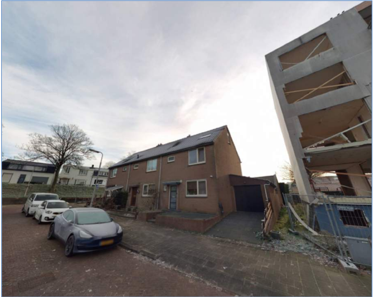
Figuur: Naastgelegen rijwoningen en te slopen appartementencomplex.
