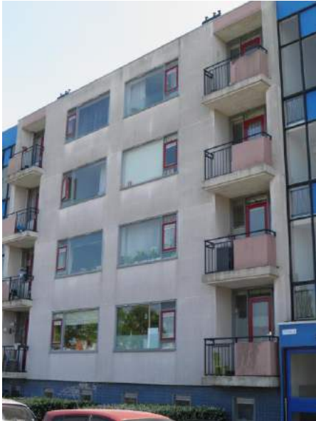
Figuur 4. Vooraanzicht van de noordelijke portiekflat.
