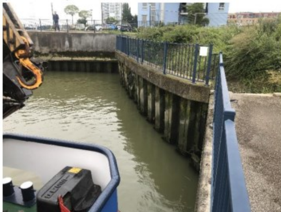
Afbeelding 4.4: Stalen damwand gezien vanaf betonnen steiger
