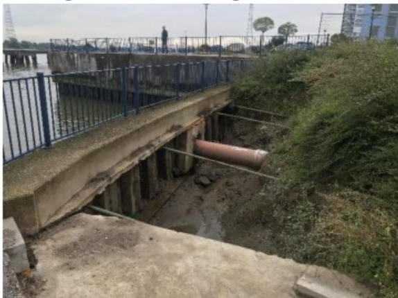
Afbeelding 4.3: Overzicht locatie met doorvoer buisleiding (sinkhole 1)
