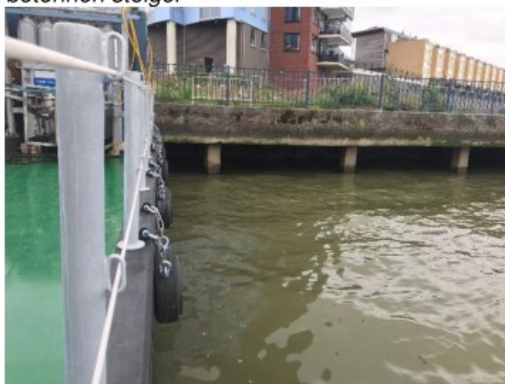
Afbeelding 4.6: Overkragende steiger vanaf waterzijde gezien
