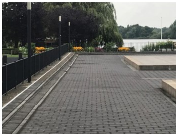
Afbeelding 4.8: Overzicht zakkingen
