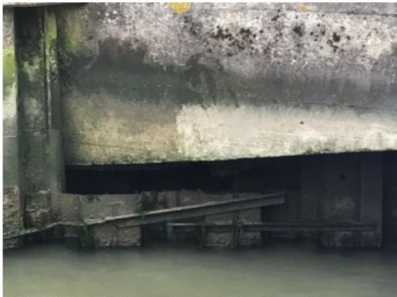
Afbeelding 4.1: Aansluiting damwand op overkragende betonnen steiger
