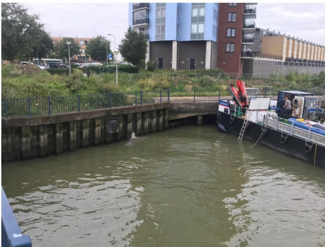
Afbeelding 1.1: overzichtsfoto damwandconstructie aan de Werfkade te Bolnes
