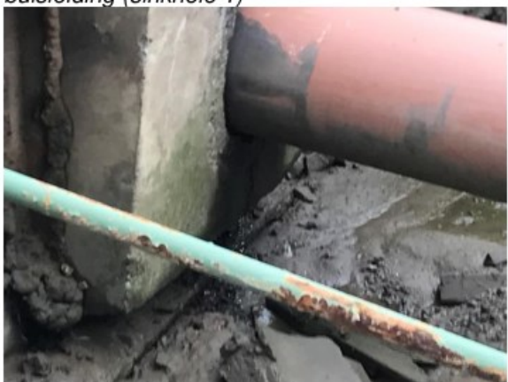
Afbeelding 4.5: Damwanddoorvoer
