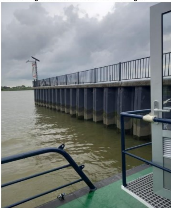
Afbeelding 4.11: Damwand, toegangskanaal
